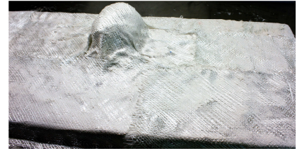
Fig. 9. De eerste laag Acrylhars met daarop de eerste laag Triaxiaal doek.
