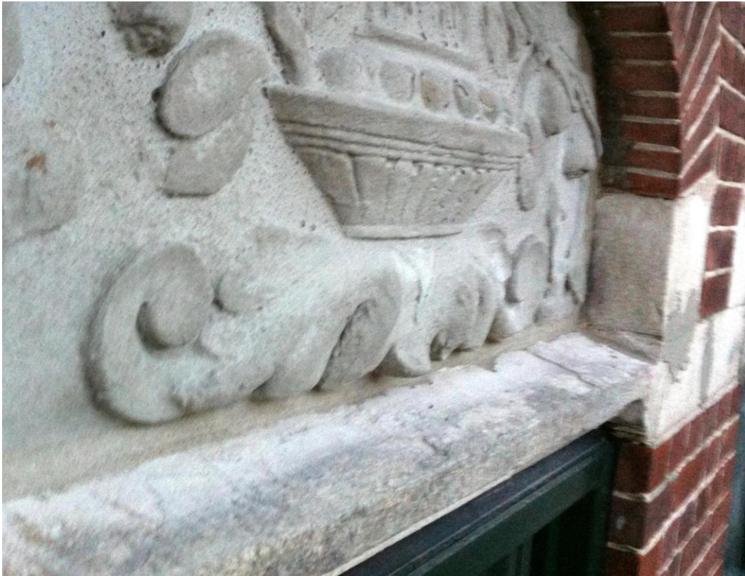
Fig. 22. Het eindresultaat in beton terug geplaatst in de gevel.
