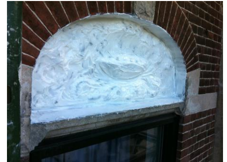
Fig. 3. Het ornament is voorzien van een laag siliconen met een dikte van 0,5 cm.
