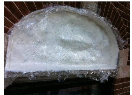
Fig. 4. De siliconen zijn bedekt met folie en vervolgens glad gestreken.
