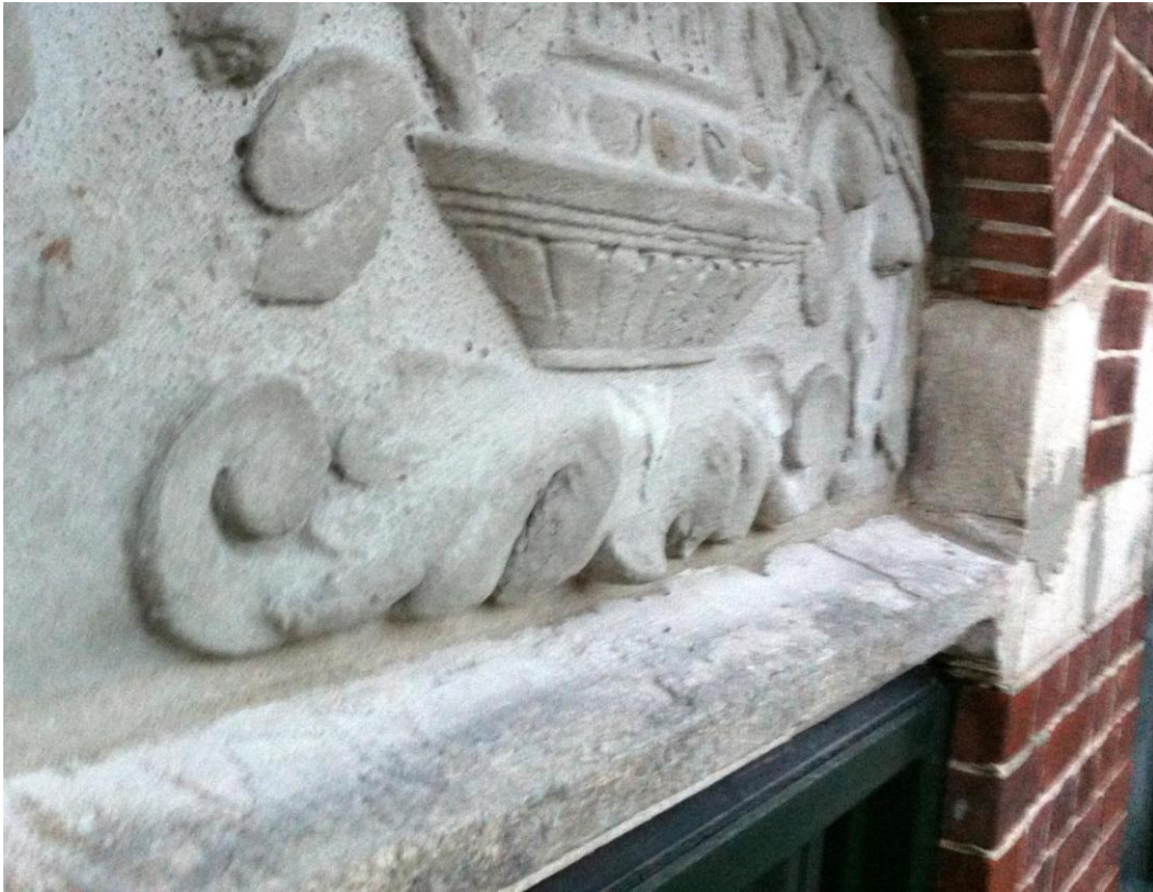
Fig. 22. Das Endresultat in Beton, zurück auf der Fassade.
