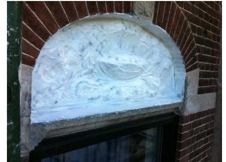
Fig. 3. Das Ornament, versehen mit einer ca. 0.5cm dicken Schichte Silikon.
