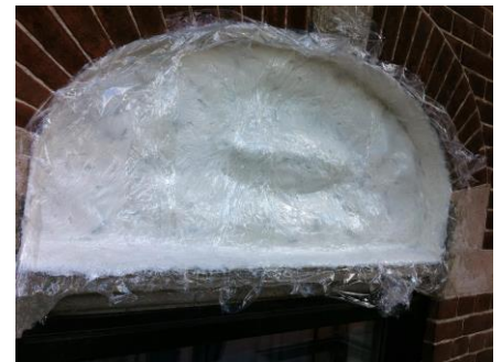
Fig. 4. Das Silikon wird mit Folie bedeckt und anschließend geglättet.
