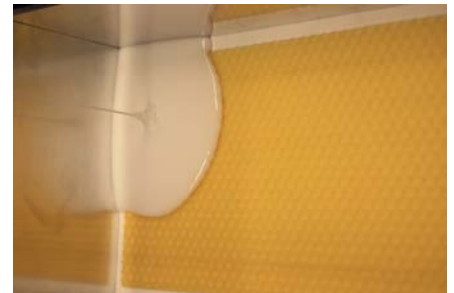
Abb. 4: Mit einem dünnen Strahl wird das Silikon von 1 Stelle aus gegossen. Hierdurch wird die Luft beim Fließen verdrängt.
